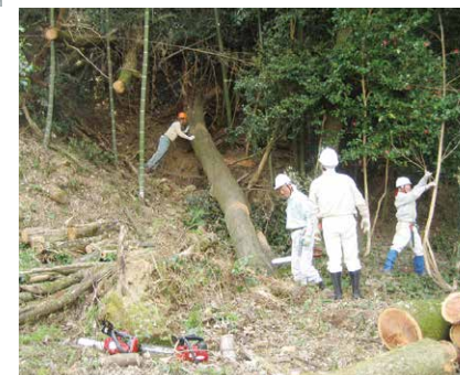
台風被害の復旧作業
